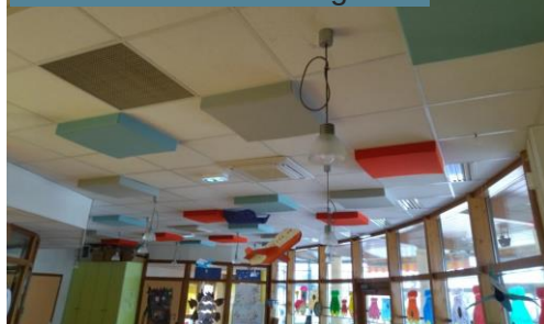
Multi-accueil de Delme : salle de vie et la salle de bain des grands
